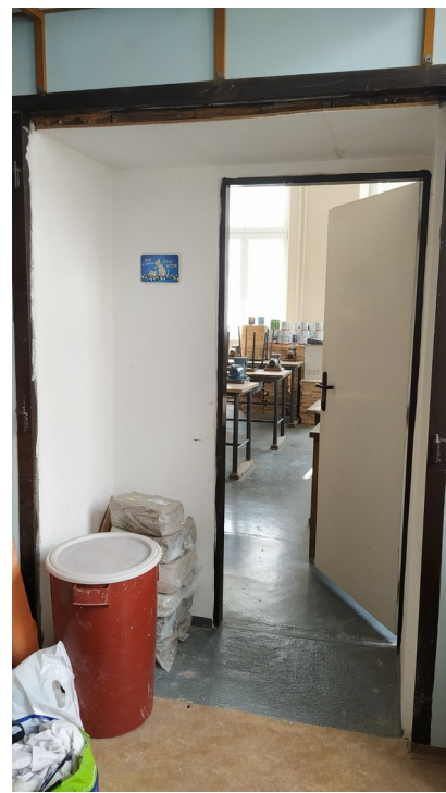
oprava ostění dveří kabinetu
